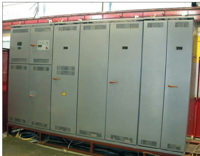
Рис. 3. Фотография преобразователя частоты ВПЧА-630-6,3/6,0-50
