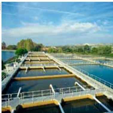
Установка для очистки сточных вод
